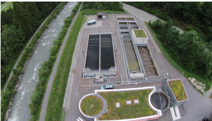
ARA-Anlage im Kanderspitz, links Engstligen, rechts Kander. Von links nach rechts: 2 Nachklärbecken, Vorklärbecken, Biologiebecken mit Gebläsestation, vorne Betriebsgebäude.
