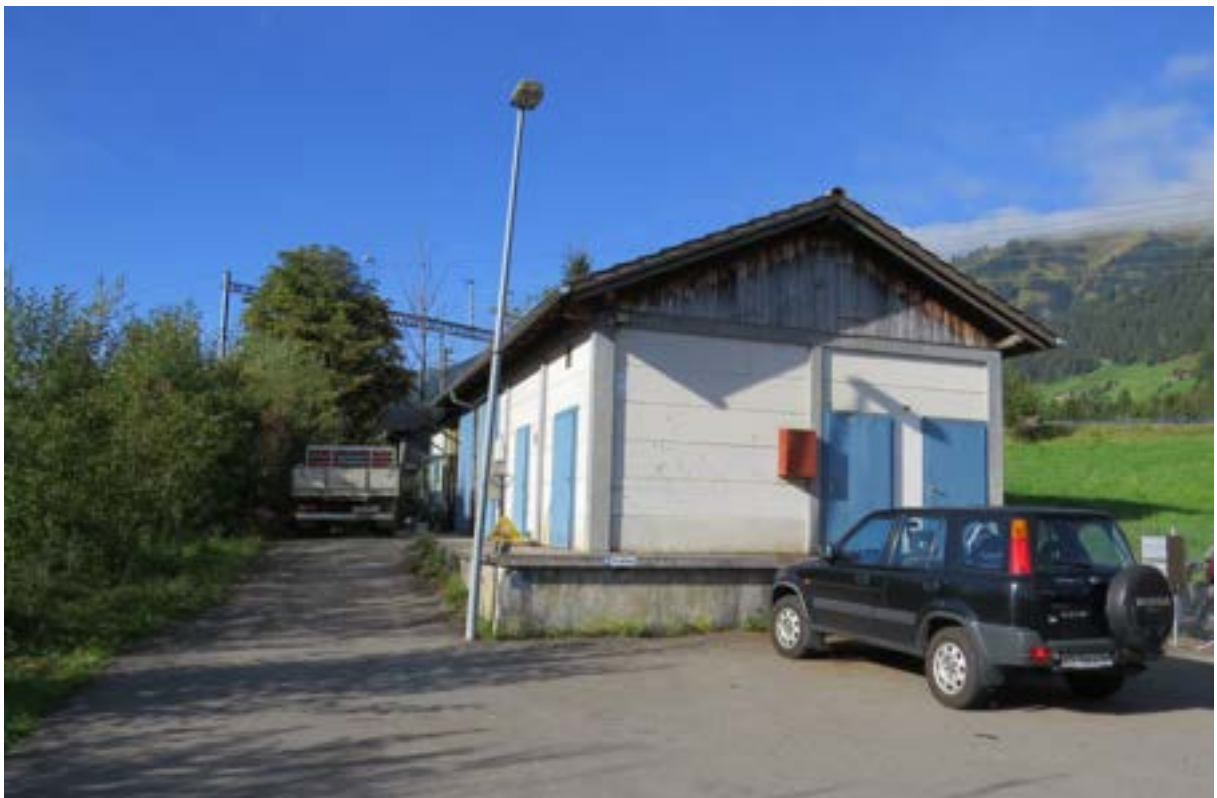
Abbildung 4: Schwandistrasse 13a, Rohmateriallagerhaus
