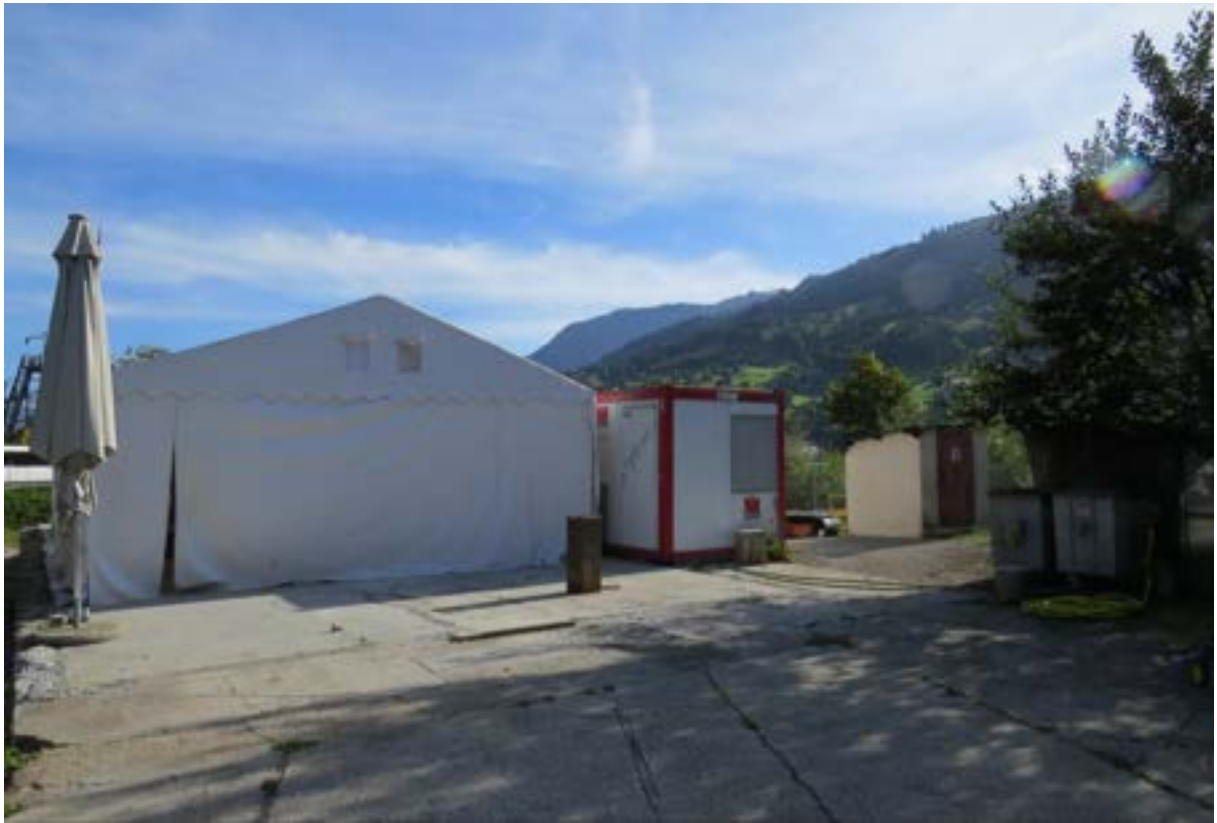
Abbildung 5: Vorplatz vor abgebrochenem Fabrikgebäude.
