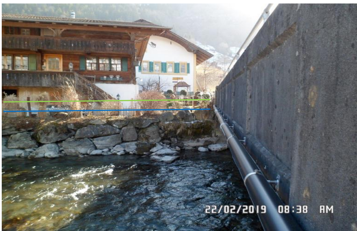
Abbildung: Auswirkungen Variante mit (blaue Linie) und ohne (grüne Linie) Sohlenabsenkung bei der Brücke Widigasse
