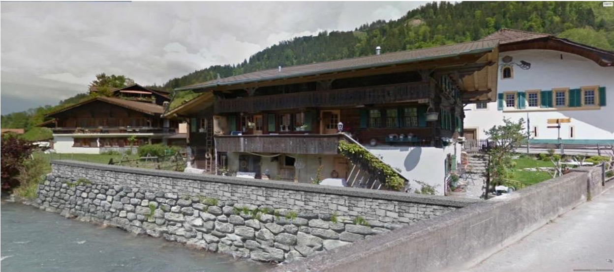
Abbildung: Beispiel einer möglichen Gestaltung / Materialisierung Erhöhung Ufermauern in Kanderbrück bei der Brücke Widiggasse
